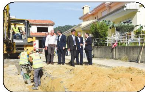
Obras lançadas a semana passada em Telhado
