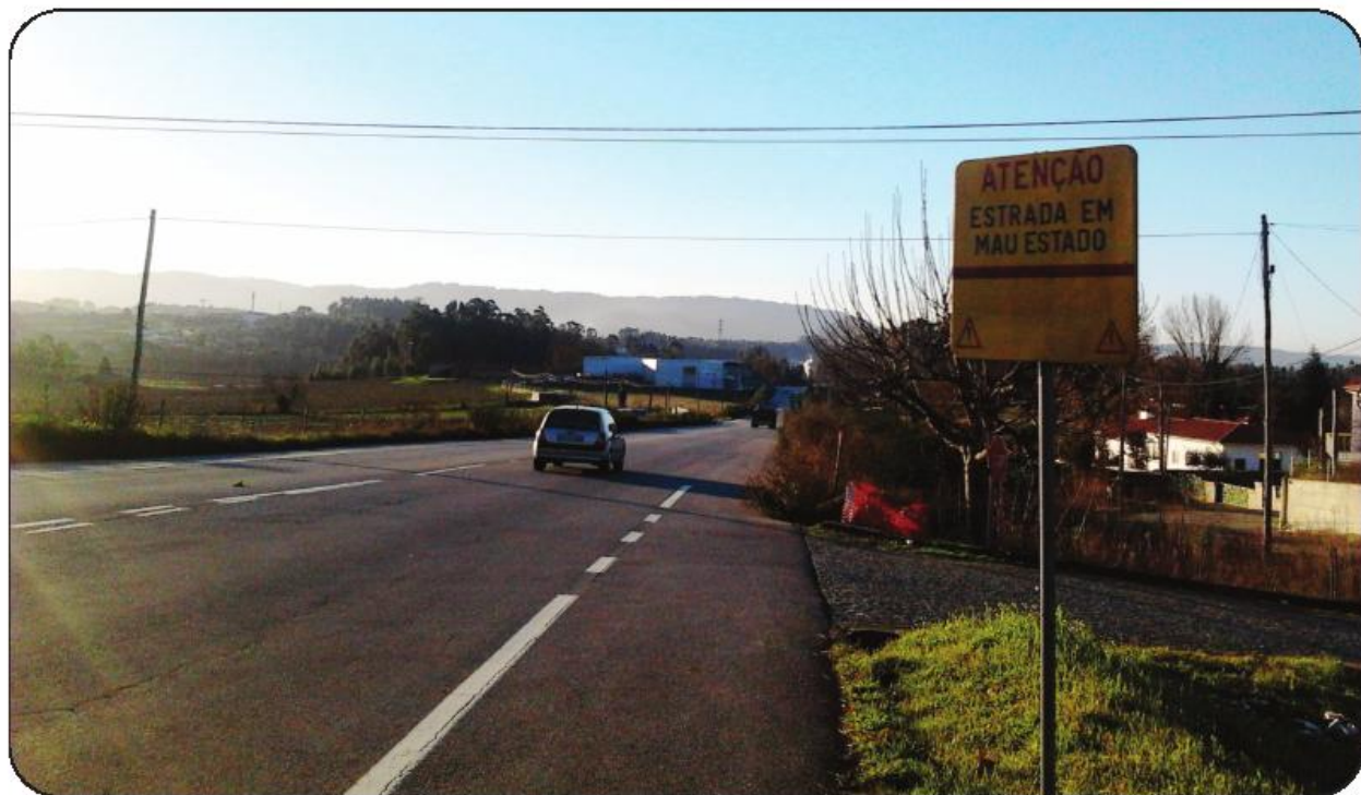
Município colocou sinalização advertindo os condutores do mau estado do piso
