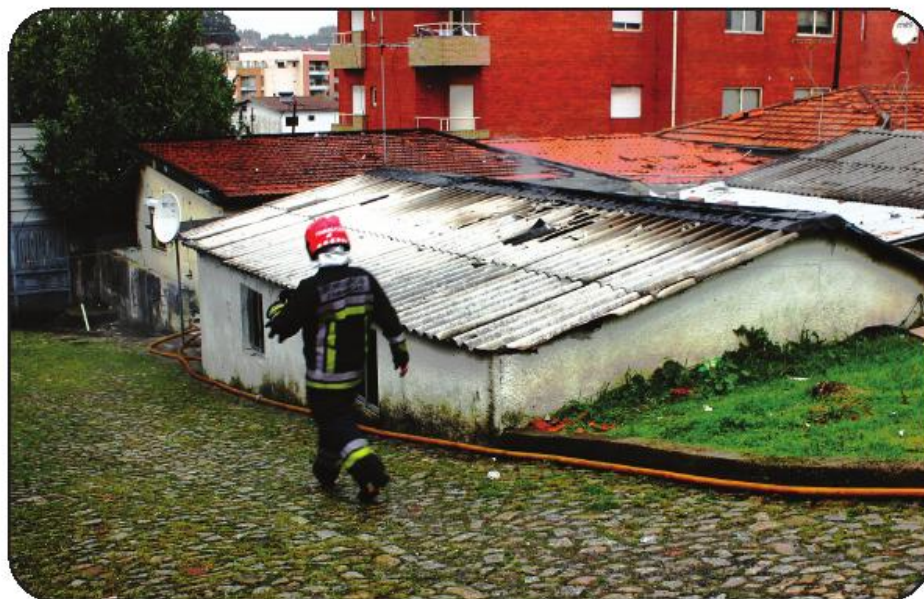
Fogo destruiu uma habitação por completo, e danificou uma outra, contígua
