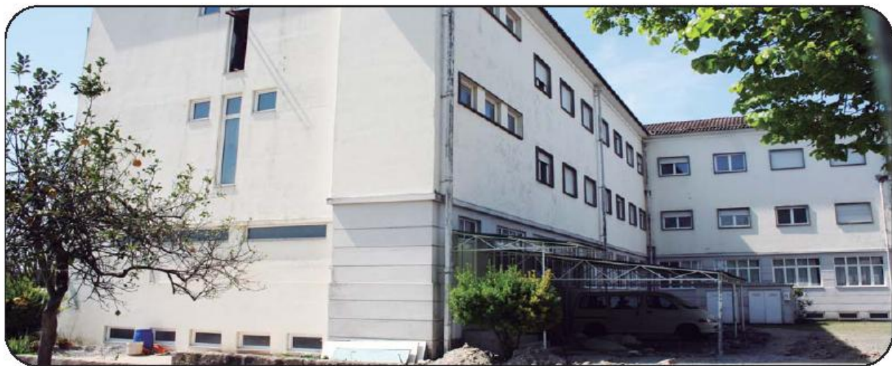
Este é o edifício que está a ser intervenido para adaptar a lar
